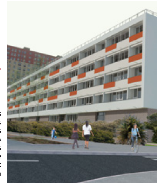
Bâtiment rue du 19 mars 1962
