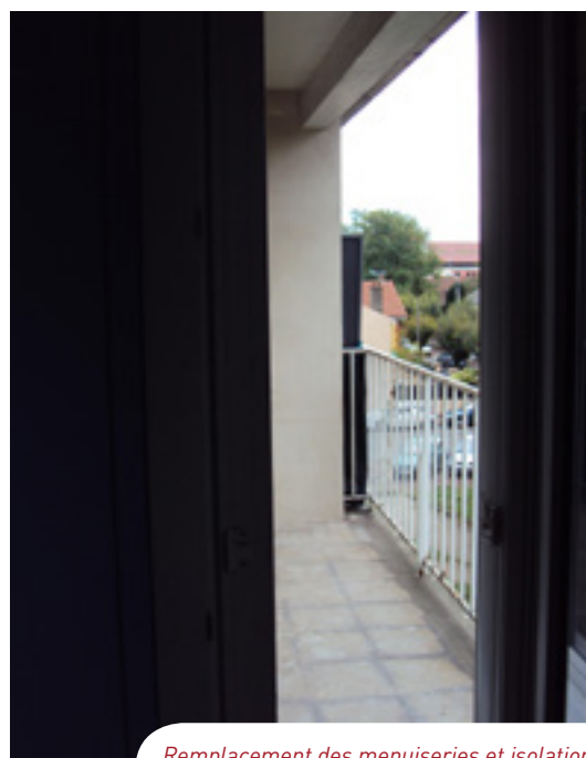
Remplacement des menuiseries et isolation
