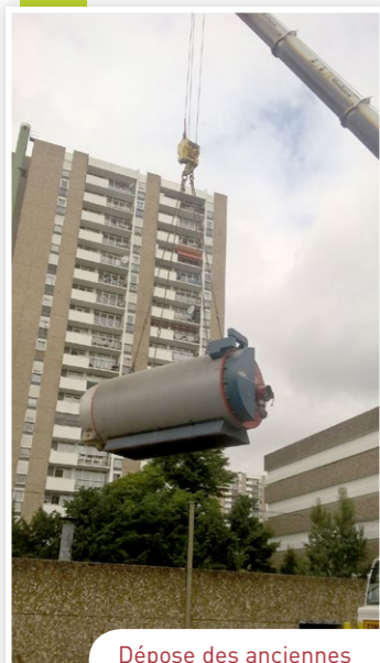
Dépose des anciennes installations.
