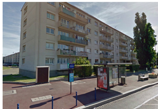
► Bâtiment A état existant
