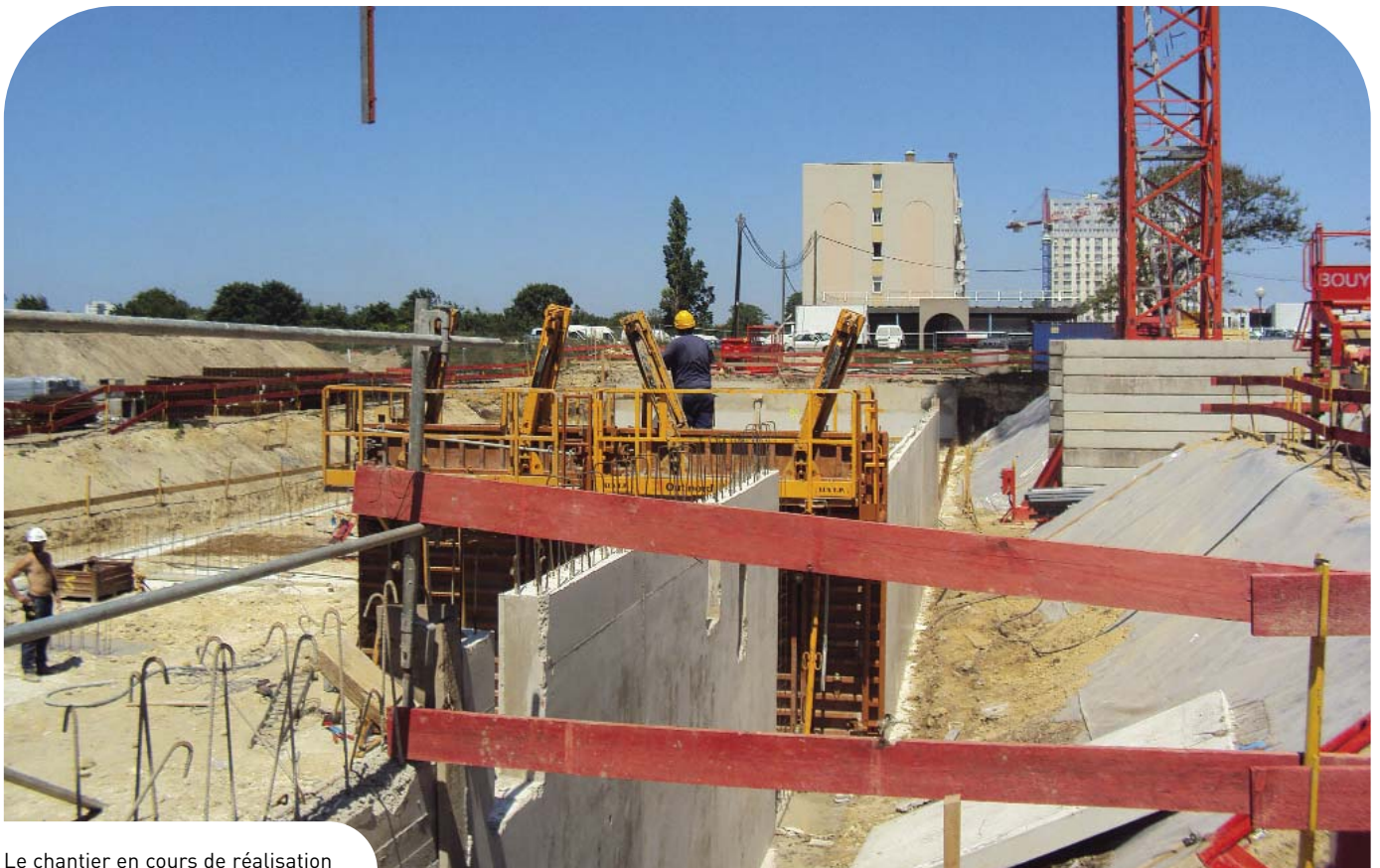
Le chantier en cours de réalisation
