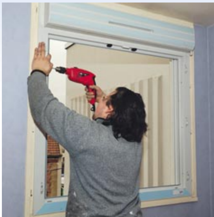
La modernisation des menuiseries permet aux locataires de réaliser des économies d'énergie tout en optimisant leur confort.
