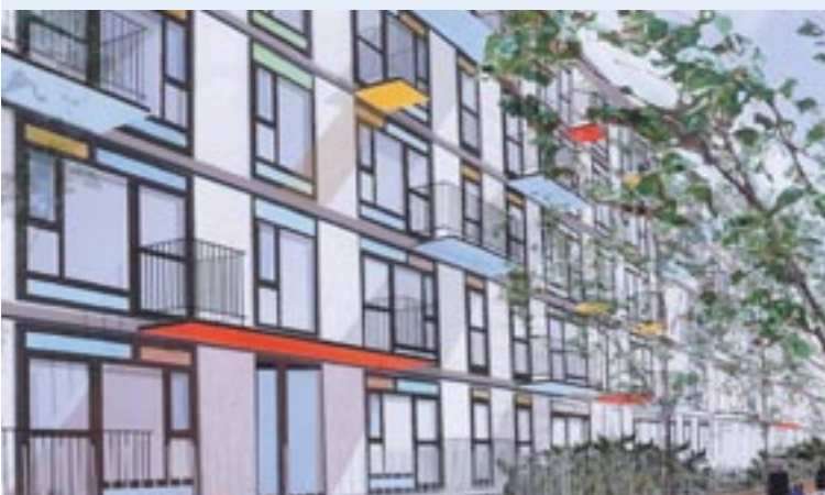
Montfermeil, Les Bosquets : projet de réhabilitation des immeubles 14 et 14A.
