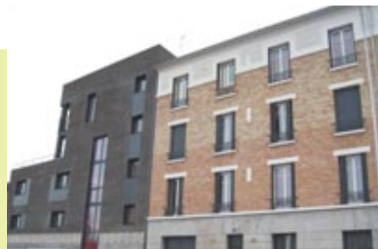
La Courneuve, 68 et 70 avenue du Général Leclerc.
