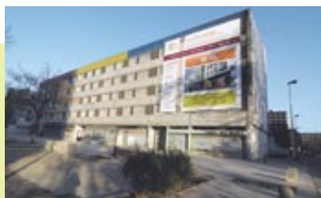
La Courneuve, l'immeuble « Petit Balzac » avant sa démolition, fin 2007.
