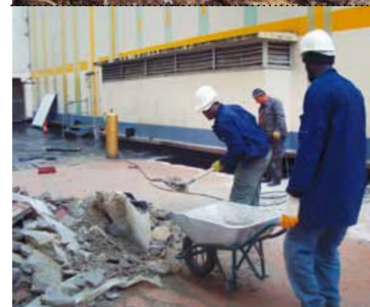
De haut en bas : le projet de construction de l'îlot Nougaro à Pierrefitte, la construction de l'opération Gabriel Péri 2 au Blanc-Mesnil, la residentialisation de la cité Pont-de-Pierre à Pantin et la réhabilitation de l'îlot Gendarmerie à Epinay-sur-Seine.
