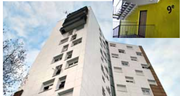
La cité Pont de Pierre à Pantin réhabilitée.
