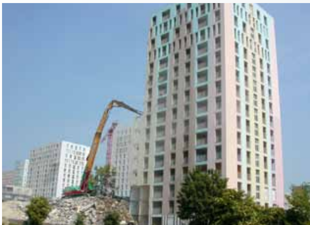
Démolition de l'immeuble Baudelaire.
