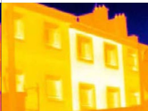
Après travaux de réhabilitation
