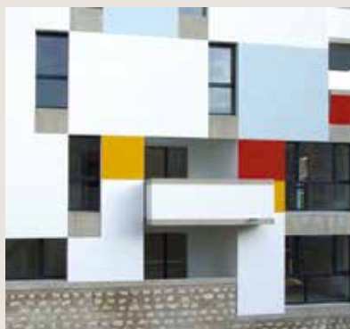
MONTFERMEIL Berthe Morisot 41 LOGEMENTS Architecte : Vincen Cornu
