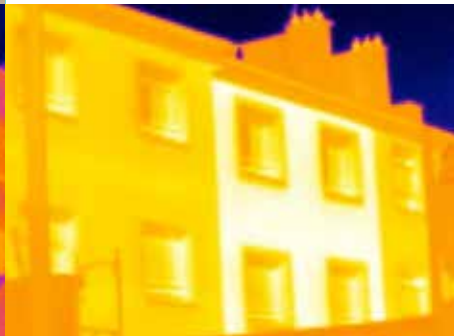
Après travaux de réhabilitation
