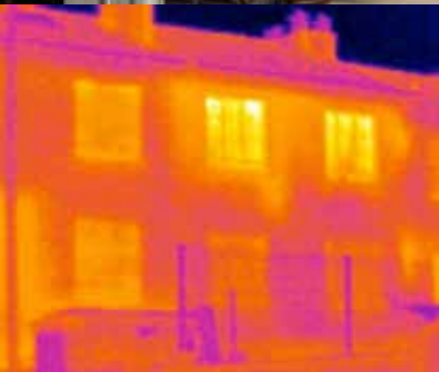
Avant travaux de réhabilitation
