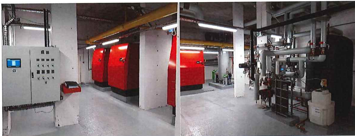
Rénovation de la chaufferie Résidence Maurice Grandcoing à Villetaneuse.
